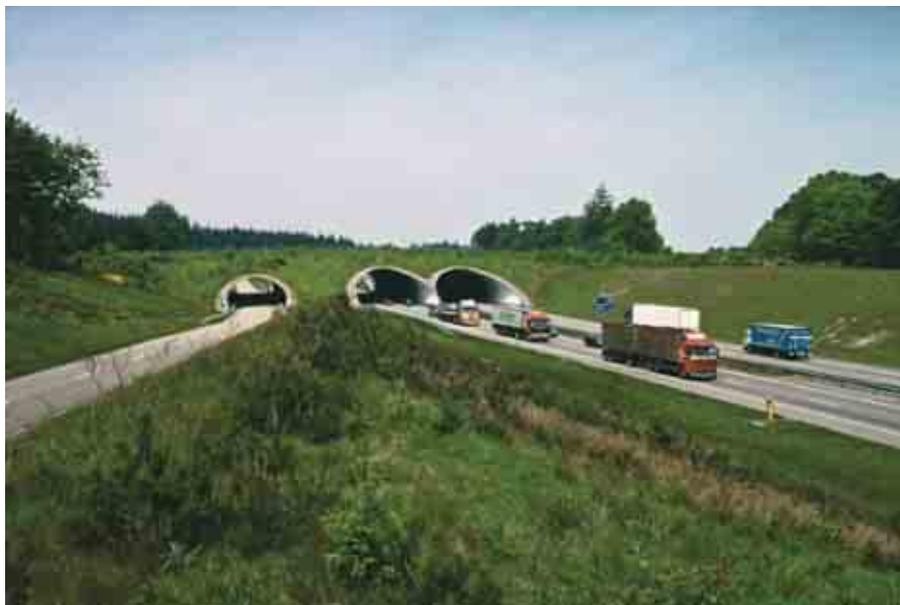
Figura 2.38: Esempio di ecodotto- Infra Eco Network Europe
