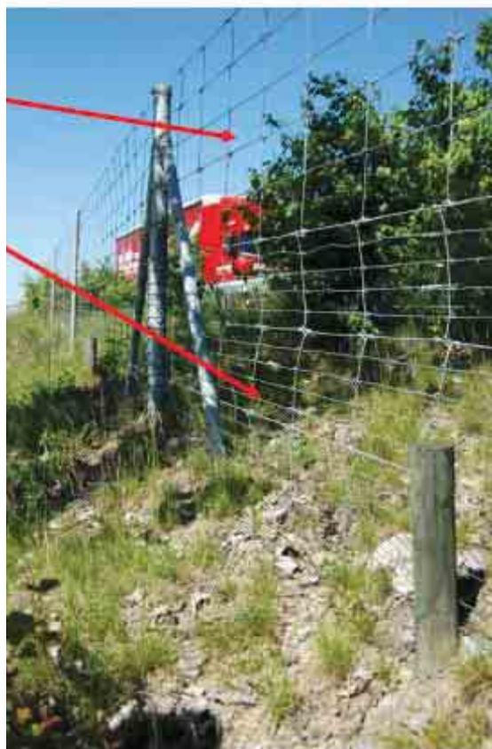
Figura 2.41 - Esempio di rete a maglia posta lungo una strada ad intenso traffico per evitare l'attraversamento
