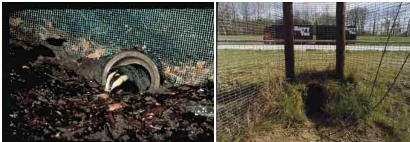
Figura 2.33 - Esempi di sottopasso a sezione circolare- Infra Eco Network Europe
