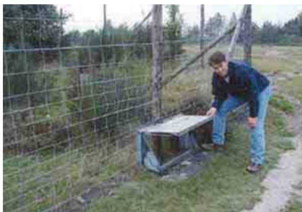
Figura 2.42 - Esempio di cancelletto con apertura unidirezionale
