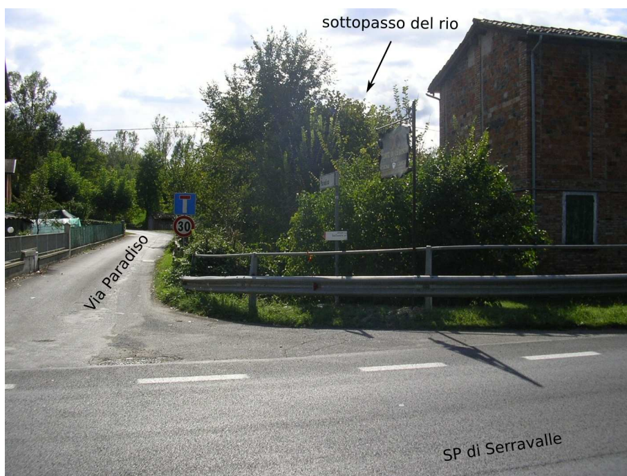
Figura 7.9 – l'area del sottopasso, guardando verso monte
