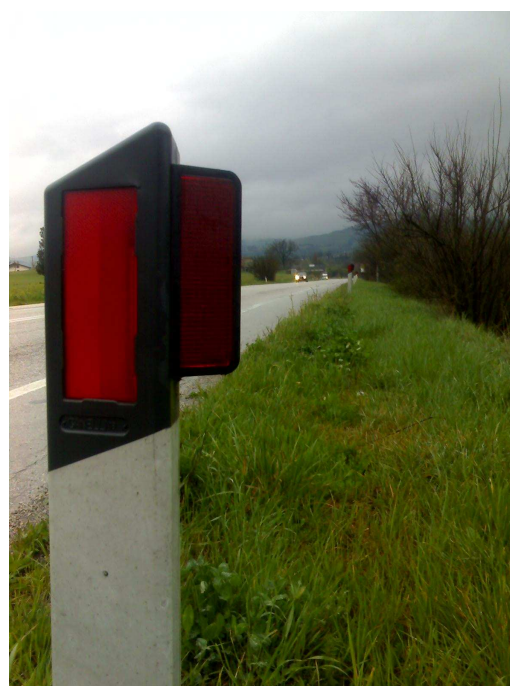
Esempio di installazione di dissuasori ottici
