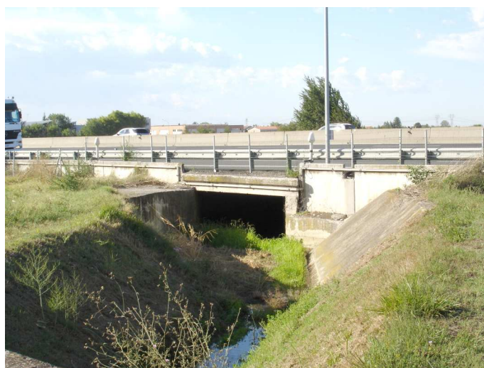
Figura 5-5- Imbocco sud del canale sotterraneo del T. Podice sulla A1. Dimensioni: circa 4 m di ampiezza per 1,5 m di altezza.
