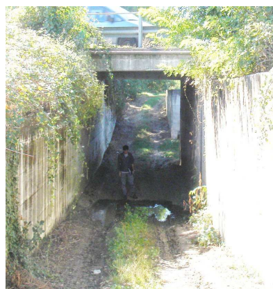
Figura 1-20 – Sottopasso A, ripreso da nord
