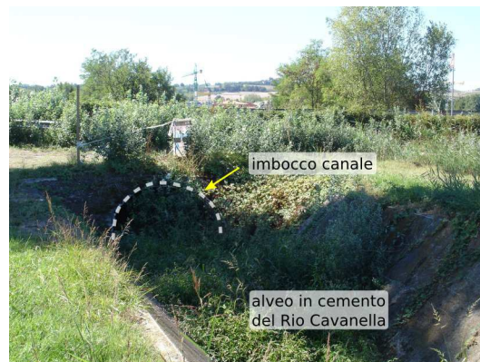
Figura 1-22– Sottopasso C, ripreso da nord
