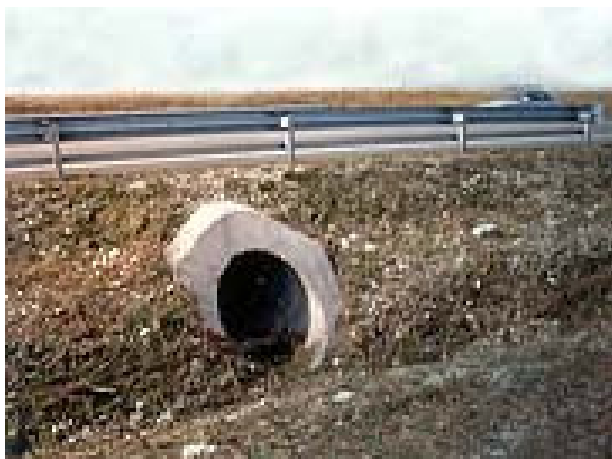
Fig. 5-1 - Esempio di sottopasso faunistico (non completamente funzionale) per piccola media fauna - Infra Eco Network Europe
