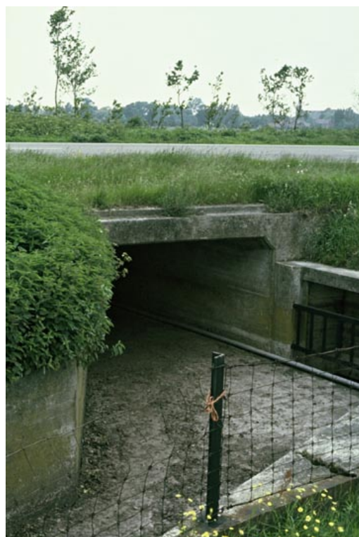
Figura 2.36 - Esempio di sottopasso a sezione rettangolare; la pavimentazione in cemento rende il sottopasso meno gradevole alla fauna- Infra Eco Network Europe
