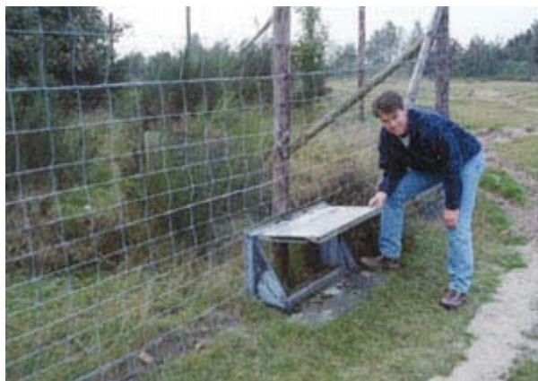
Figura 2.42 - Esempio di cancelletto con apertura unidirezionale
