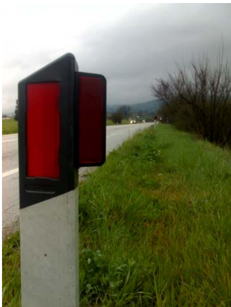
Figura 2.45 - Dissuasore riflettente per la fauna selvatica montato su paracarro lungo una strada provinciale.
