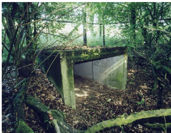
Figura 2.34 - Esempio di sottopasso a sezione rettangolare- Infra Eco Network Europe
