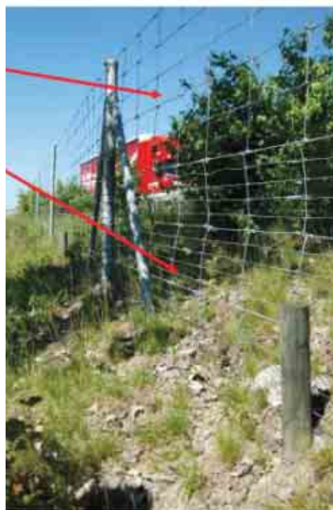
Fig. 5-14 - Esempio di rete a maglia diversificata posta lungo una strada ad intenso traffico per evitare l'attraversamento
