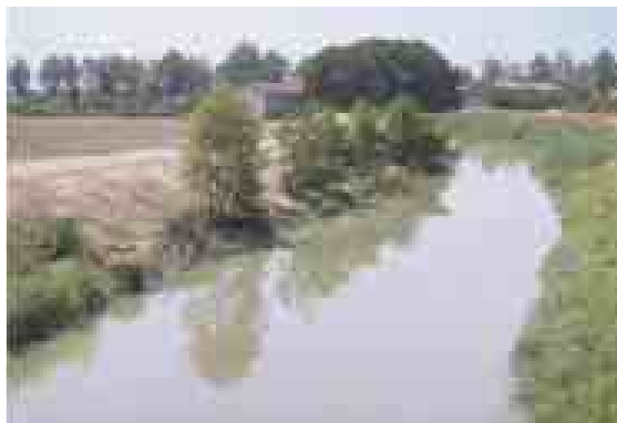
Figura 2.9 - Esempio di manutenzione effettuata preservando una serie di ontani presenti sulla sponda.
