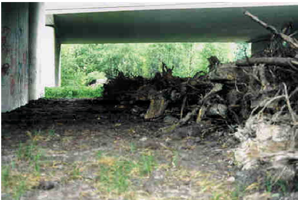
Fig. 5-10 - Esempio di sottopasso per fauna di grandi dimensioni- Infra Eco Network Europe
