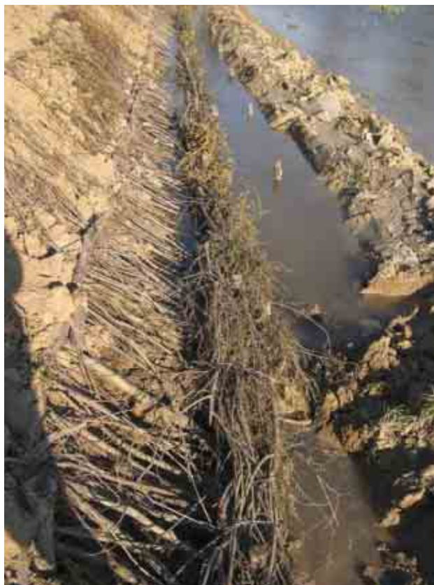
Figura 2.7 - Esempio di copertura diffusa con ramaglia viva applicata lungo le sponde della parte terminale del Fiume Uso (RN)
