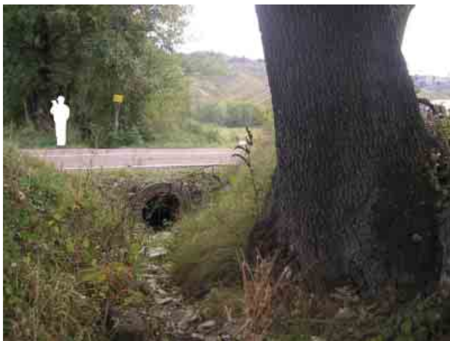
Figura 9.4 – particolare dell'attraversamento idraulico del Rio Palazzo
