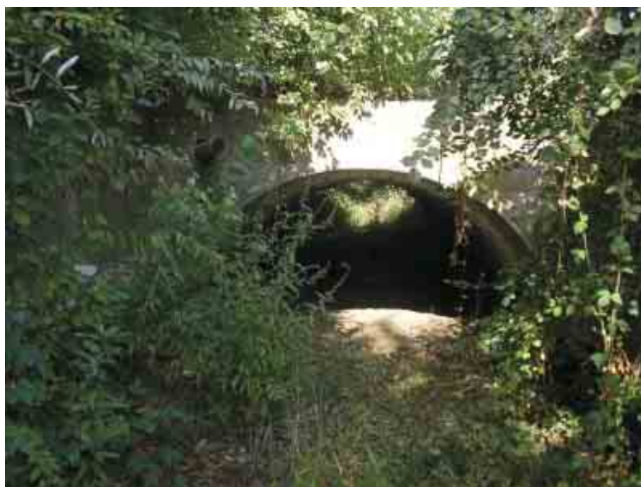
Figura 7.7 – dettaglio del sottopasso
