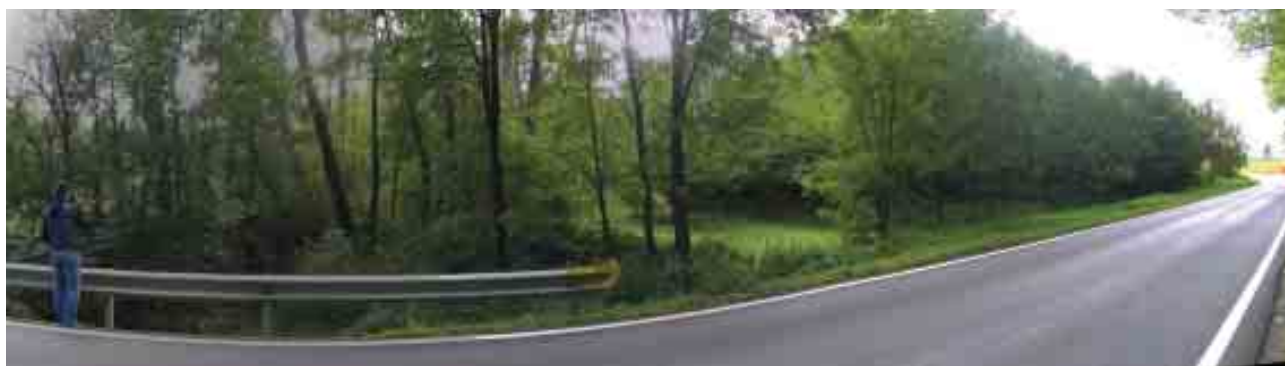
Figura 7.3 - sottopasso sul Fosso Cimisella, guardando verso monte
