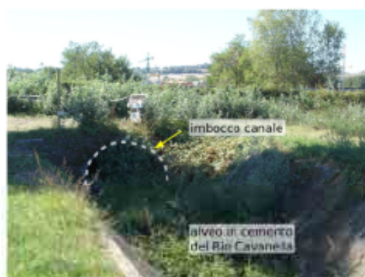
Figura 3-3– Canale sotterraneo, imbocco nord
