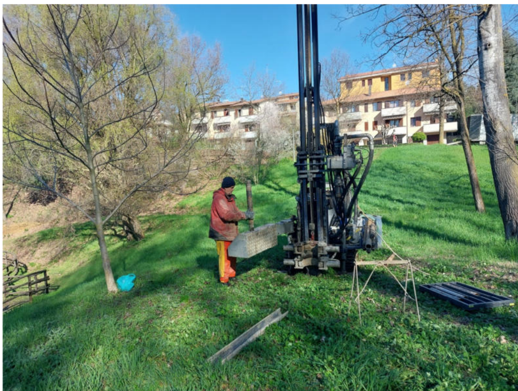
Foto 4 – Sondaggio meccanico S1 coronamento
