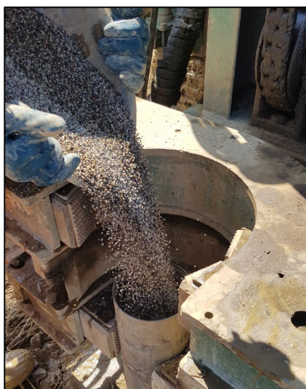
Foto 16 – Sondaggio S1. Inserimento ghiaio siliceo nell'intercapedine rivestimento-porzione di tubo piezometrico fessurato.
