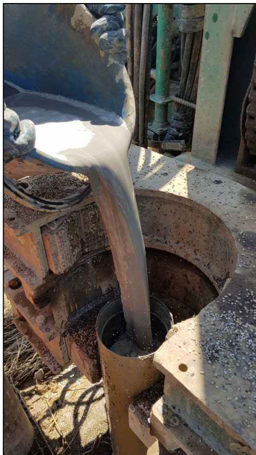
Foto 18 – Sondaggio S1. Inserimento del cemento al di sopra del tappo bentonitico.
