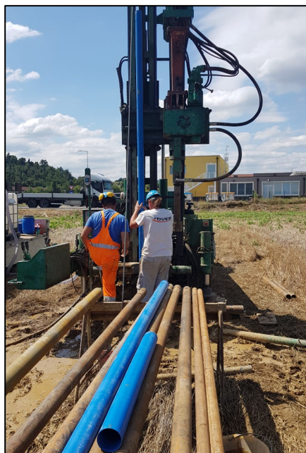
Foto 15 – Sondaggio S1. Installazione tubo piezometrico.
