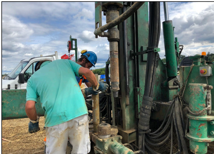
Foto 15 – Sondaggio S1. Prelievo campione C2.
