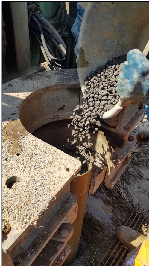
Foto 17 – Sondaggio S1. Inserimento bentonite al di sopra del ghiaino siliceo.
